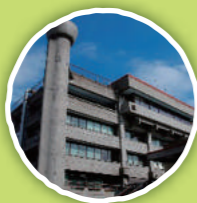
区役所本庁舎
